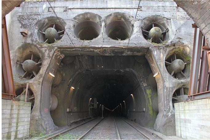
Bild 9: Blick in die Tunnelöhre mit sechs Lüftern [ 2 ]
