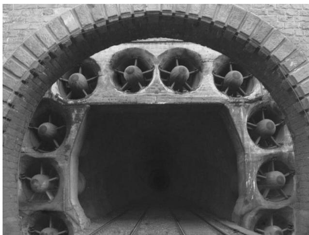
Bild 7: Nordportal des Kaiser-Wilhelm-Tunnels mit 10 Strahl-Gebläsen [ 2 ]
